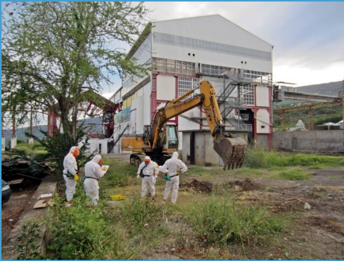
Diagnostic pour qualification des terres excavées
