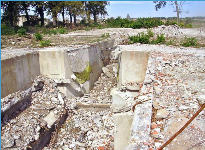
Démantèlement des infrastructures béton
