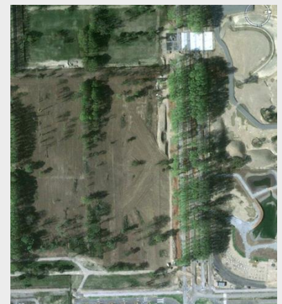
▲ Vue aérienne du site à la fin du chantier
