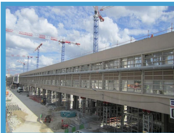
Vue du chantier côté boulevard Macdonald.
