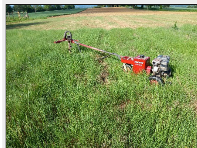
▲ Sondage à la mototarière hydraulique
