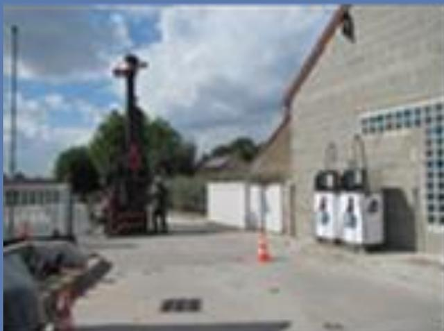
Réalisation de sondages de sols au droit des zones potentiellement polluées par les activités actuelles et passées (zones des cuves, des canalisations, de dépotage, de distribution ...)
