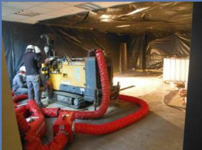
Réalisation de puits de venting et d'injection dans un local, où une zone source en COHV a été mise à jour dans les sols et les eaux souterraines.
