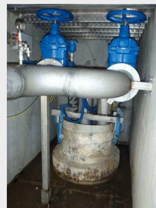
▲ Tête du forage dans la chambre de comptage
