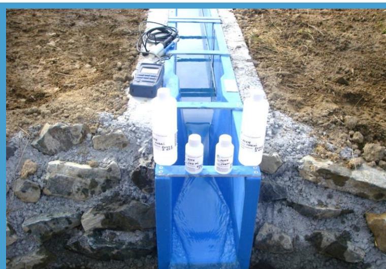
Mise en place d'un canal Venturi pour un jaugeage et suivi qualité
